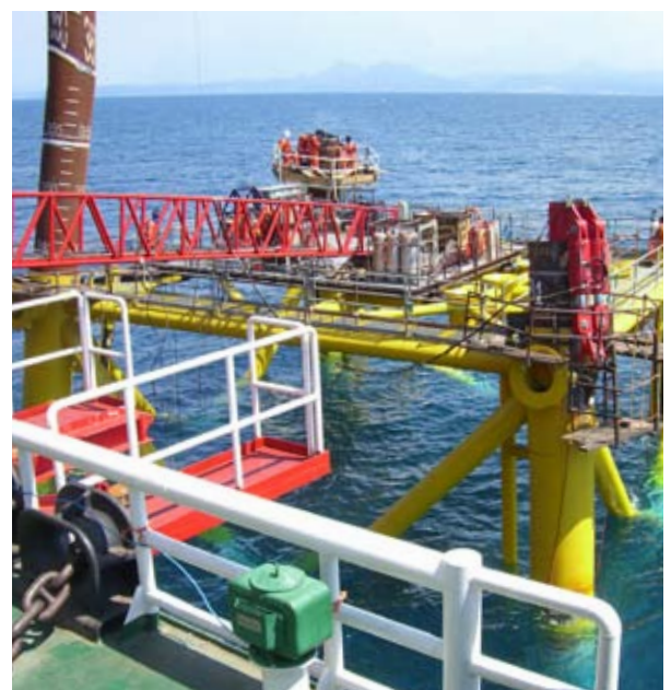
Rahmen der Pfähle des Akcakoca Jackets – Schwarzes Meer
