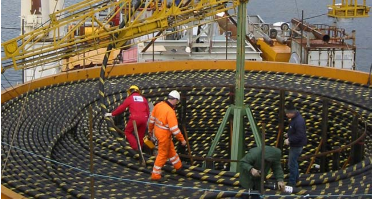
CLB Coastal Spider – Seekabelverlegung
